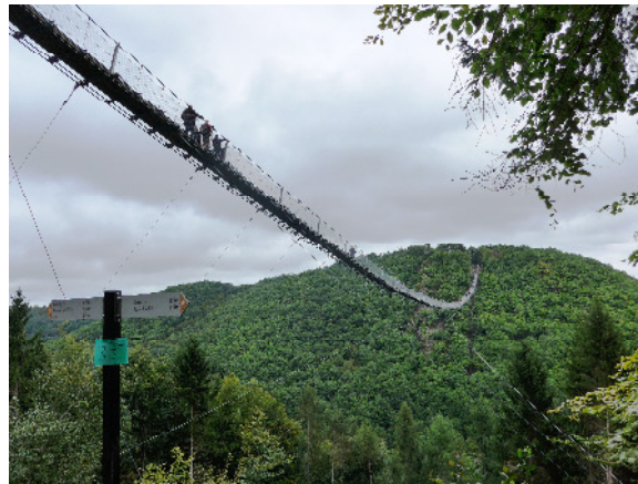
Die Brücke von unten gesehen
