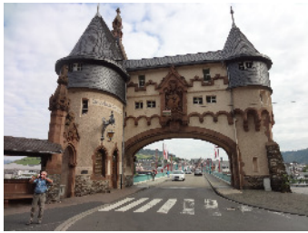
Das Brückentor von Trambah
